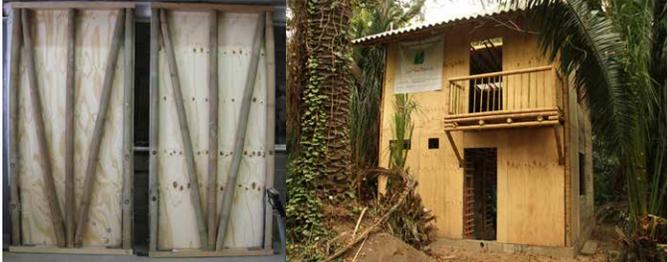
Biopanel® es de fácil ensamblaje y bajo costo; con capacidad para resistir cargas verticales y acciones horizontales dinámicas (originadas por sismos o huracanes), de acuerdo con los reglamentos de diseño y construcción vigentes.
